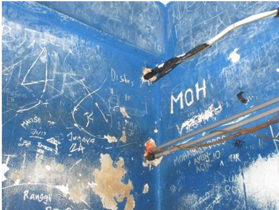
Keadaan dinding di dalam Ruang Khas OKT
