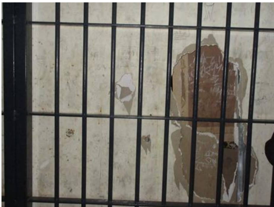
Keadaan dinding di dalam Ruang Khas OKT
