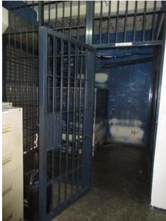
Pintu masuk ke dalam Ruang Khas OKT
